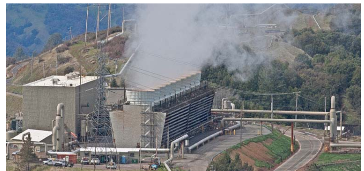
شکل (۳)- نیروگاه Ridge Line در منطقه زمین گرمایی گیزرز به ظرفیت تولید ۷۶ مگاوات [14]
